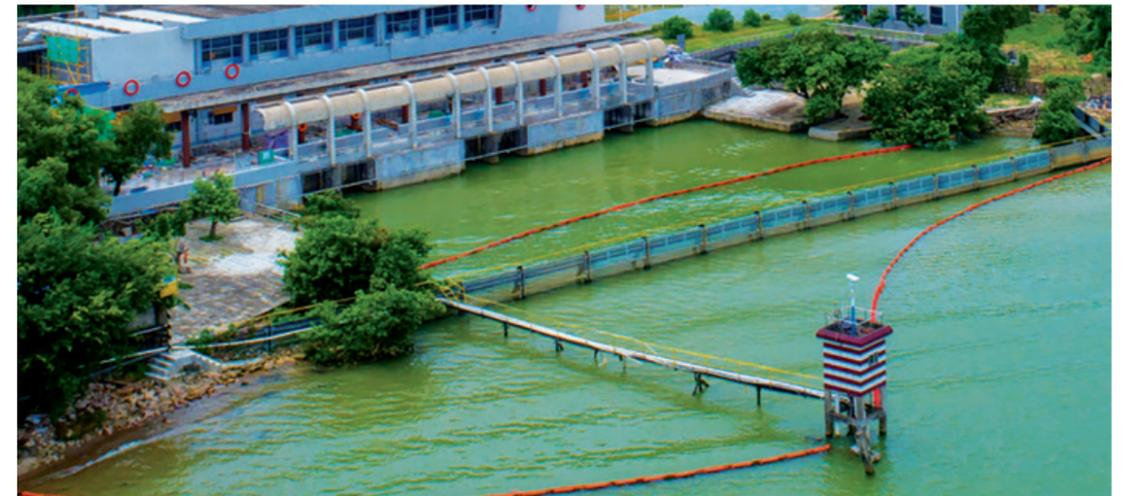
在泵站取水口外围安装两层防油栏
